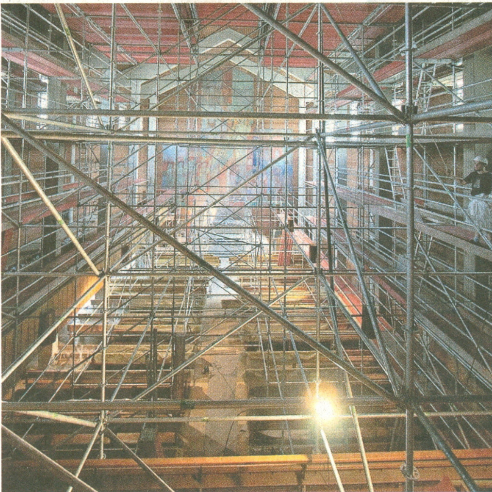
Ein riesiges Gerüst steht im hinteren Teil der St. Matthäuskirche, der vordere Teil samt dem Altarbild wurde bereits vom Ruß befreit. Foto: Günter Distler
